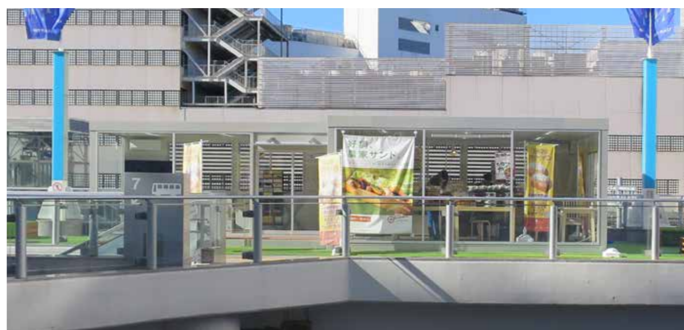
プロジェクト2 カシワテラス ユニットハウス仮設運用実験
