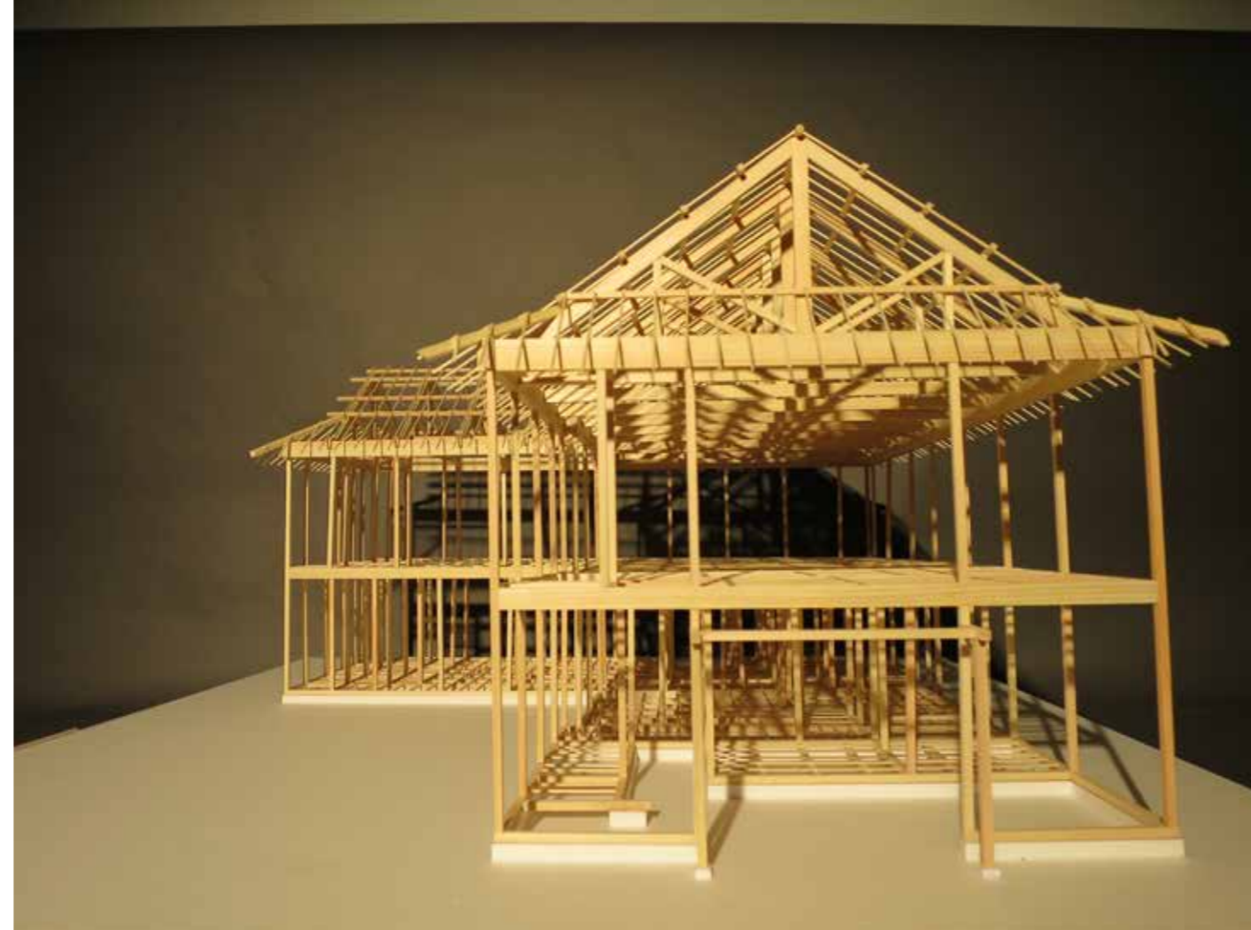
プロジェクト演習2014 旧協働会館 軸組模型 Timber frame model
